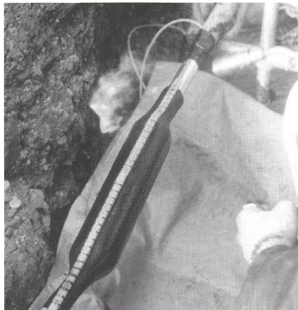
Installationen einer XAGA-500-Verbindungs-muffe
