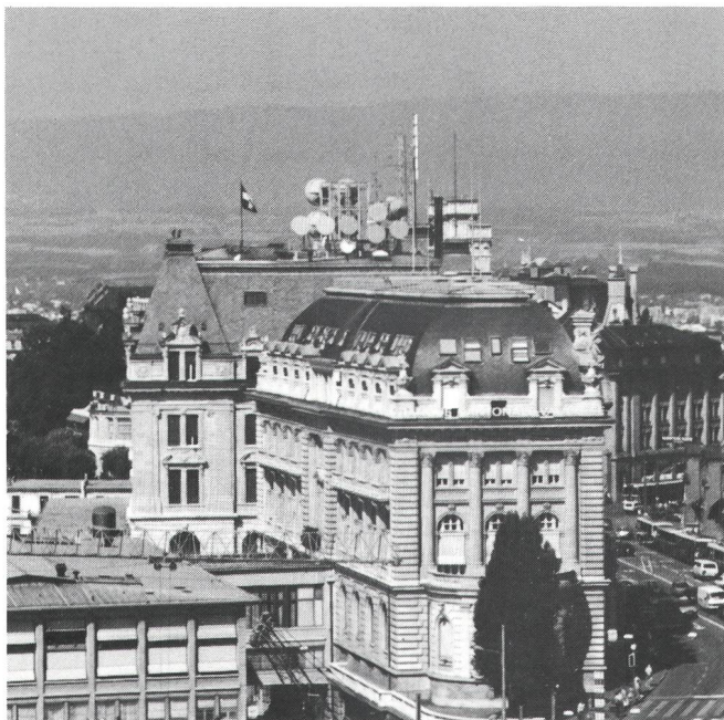
Fig. 2 Installation de St-François vue depuis le toit de l'immeuble (lieu 5). Les antennes les plus petites, rondes, sont dirigées vers le Mont-Pèlerin, les plus grosses, partiellement cachées, vers La Dôle. La place St-François se trouve entre la poste et l'église (lieux 3A-3D)
