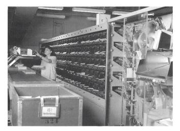
Fig. 8 Feinsortiermaschine
