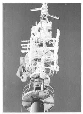
Fig. 3 Vereisung der Antennen am Beispiel der Anlage Hoher Kasten
