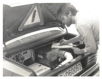
Fig. 4 Im Versuchswagen eingebaute Batterie und Messgeräte
