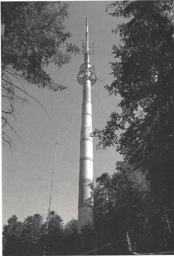
Fig. 2 Der 65 m hohe Hauptmast Links dahinter ist die ausge- fahrne Notantenne sichtbar
