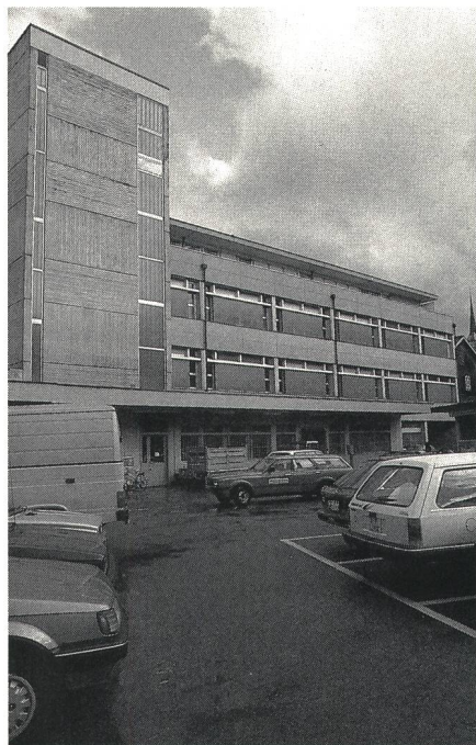
Fig. 4 Das Post- und Telekommunikations-Betriebsgebäude in Burgdorf
