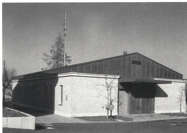
Fig. 1 Telefonzentrale Aadorf : ein individuell gestaltetes PTT-Typenbau D3
