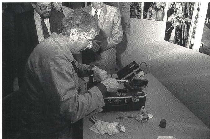
Fig. 6 Die Arbeit am Glasfaser-Spleissgerät erfordert Erfahrung und Fingerspitzengefühl
