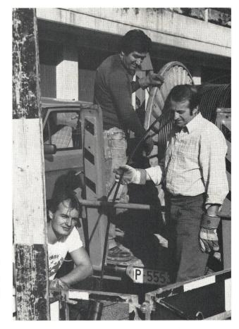
Les câbles à fibres optiques, tel que celui tiré dans une localité du canton du Valais, offrent une capacité de transmission largement supérieure à celles des câbles traditionnels, pour un encombrement réduit
