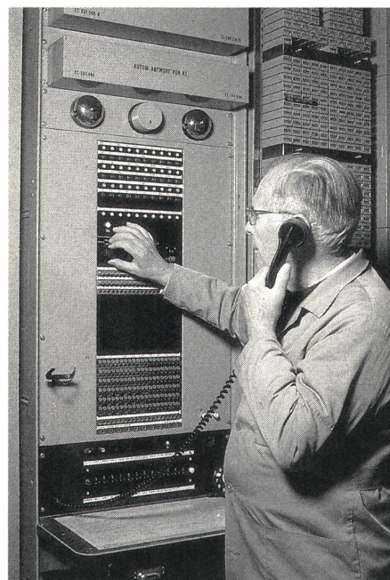
Dieser «Monitor» diente der Belegungsbeobachtung sowie der Prüfung und Messung der interzentralen Verbindungsleitungen
