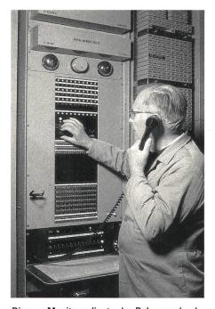
Dieser «Monitor» diente der Belegungsbeobachtung sowie der Prüfung und Messung der interzentralen Verbindungsleitungen
