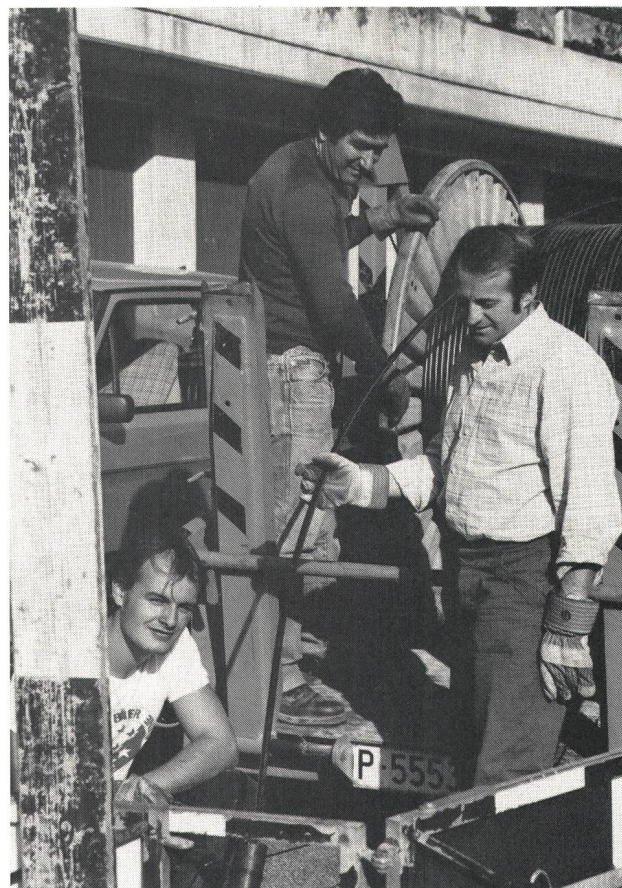
Les câbles à fibres optiques, tel que celui tiré dans une localité du canton du Valais, offrent une capacité de transmission largement supérieure à celles des câbles traditionnels, pour un encombrement réduit
