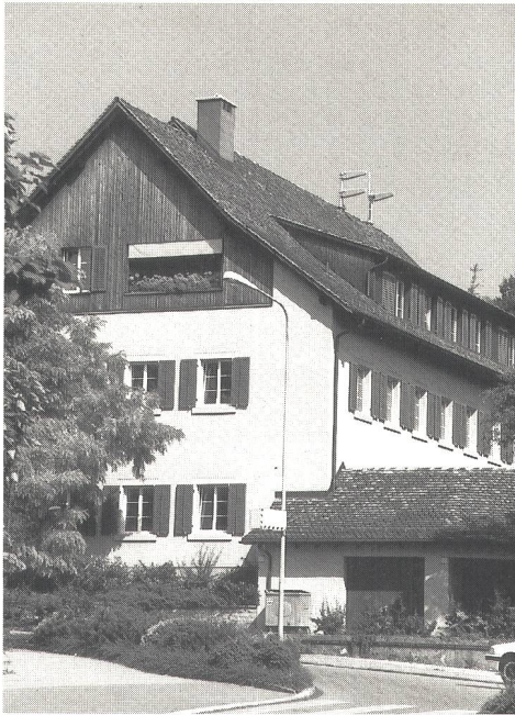
Fig. 2 Beispiel einer Basisstation Natel C Gut integrierte Antennenanlage für 16 Kanäle mit Diversity
