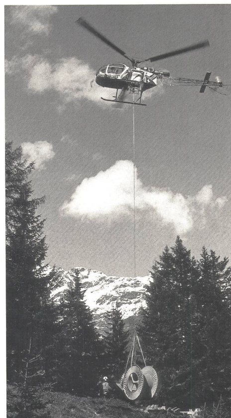
Fig. 6 Transport von Kabeltrommel und Montagematerial in unwegsamem Gelände
