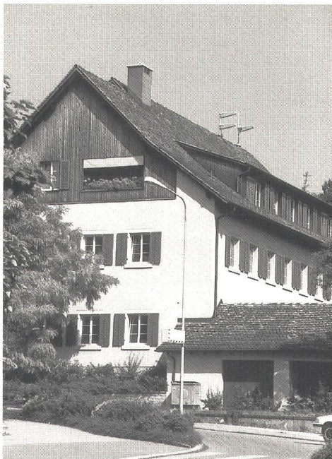
Fig. 2 Beispiel einer Basisstation Natel C Gut integrierte Antennenanlage für 16 Kanäle mit Diversity
