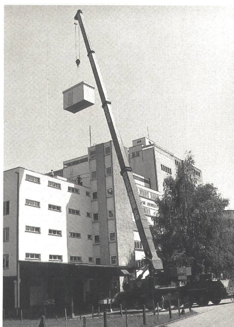
Fig. 4 Montage einer Kabine mit pneumatischem Hebekran. Zeitaufwand 1 Std.
