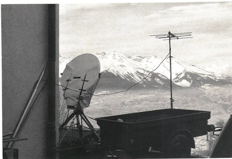
Terminal d'une liaison de secours à faisceaux hertziens entre Sion et Nendaz
