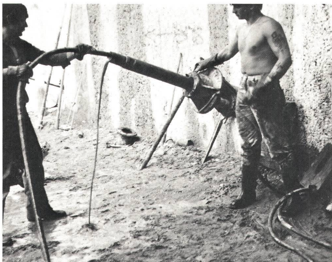
Fig. 6 Die Anker werden montiert
