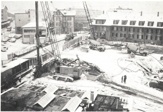
Fig. 5 Beginn der Schlitzwände
