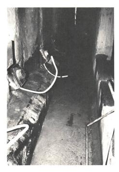
Fig. 15 Blick in den Kontrollschacht. Gut sichtbar sind die Ankerköpfe, der Betonsockel mit Abdichtung und die vertikale Schutzschicht aus einer Gummigranulatmatte
