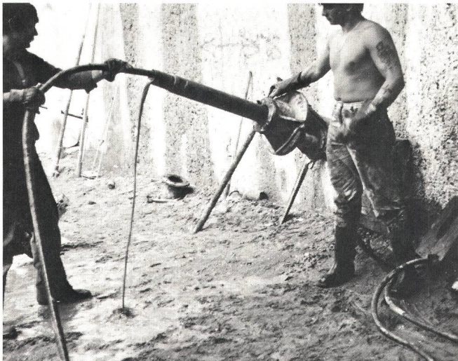
Fig. 6 Die Anker werden montiert
