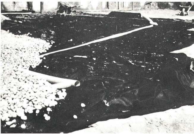
Fig. 9 Auf dem schwarzen Filtergewebe sind die Sickerrohre verlegt. Darüber ist auf der linken Seite der Sickerbeton sichtbar
