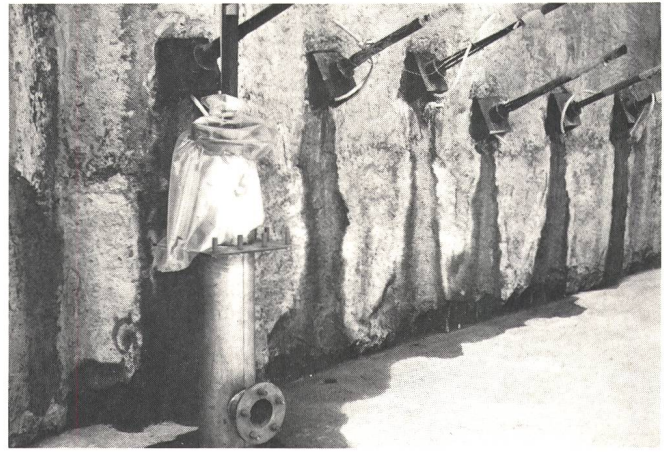
Fig. 14 Ankerköpfe mit Undichtigkeiten, vorne ein Grundwasserabsenk-schacht
