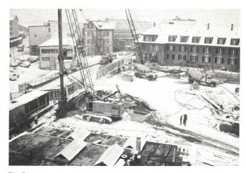
Fig. 5 Beginn der Schlitzwände
