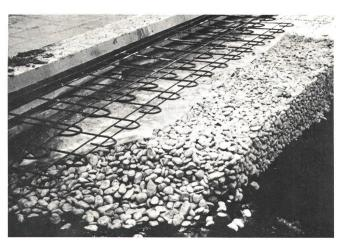
Fig. 11 Die PE-Folie verhindert, dass Zementflüssigkeit der Betonplatte in den untenliegenden Sickerbeton fliessen kann
