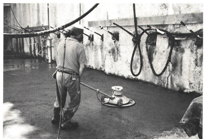
Fig. 12 Zur Aufnahme der Abdichtung muss die Oberfläche der unteren Betonplatte geschliffen werden
