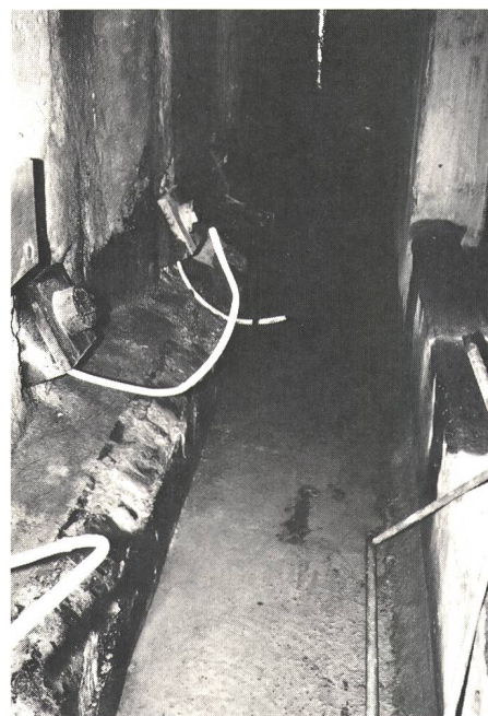
Fig. 15 Blick in den Kontrollschacht. Gut sichtbar sind die Ankerköpfe, der Betonsockel mit Abdichtung und die vertikale Schutzschicht aus einer Gummigranulatmatte
