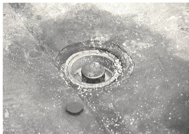
Fig. 12 Dachwasserabläufe sind gegenüber der Dachhaut stets tiefer zu verlegen
