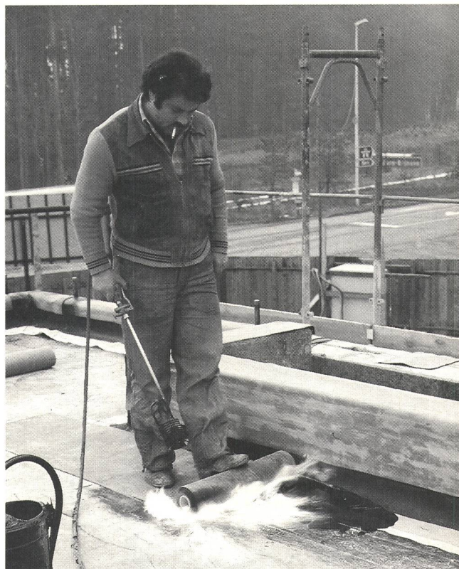
Fig. 11 Das richtige Verschweissen der Abdichtungsbahnen auf den Untergrund erfordert viel Erfahrung
