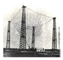
Fig. 7 Quadratische Pyramidenantenne in Marconis Poldhu-Station in England 1905 [19]
