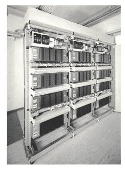
Fig. 5 Stromversorgungsanlage, bestückt mit Gleichrichtermodulen 100 A gemäss Figur 4
