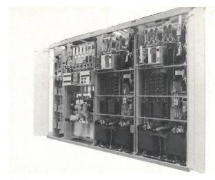
Fig. 14 Stromversorgungsanlage nach dem Prinzip der Ferroresonanz
