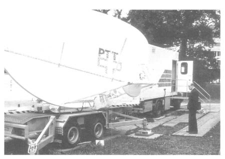
Station terrienne mobile des PTT suisses pour les transmissions de télévision et de données. L'essor de ce genre de transmission et la nécessité de beaucoup de souplesse quant à l'emplacement des stations terminales sont à l'origine de leur évolution rapide depuis la dernière exposition Telecom
