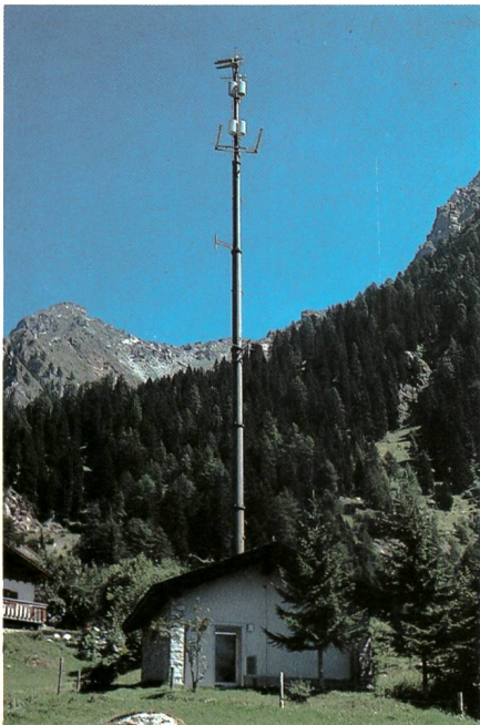
Fig. 5 Umsetzstation für den UKW- und Fernsehempfang in gebirgigem Gelände Ripetitore per la ricezione OUC e TV nelle regioni di montagna
