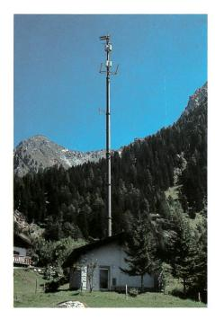
Fig. 5 Umsetzerstation für den UKW- und Fernsehempfang in gebirgigem Gelände Ripetitore per la ricezione OUC e TV nelle regioni di montagna
