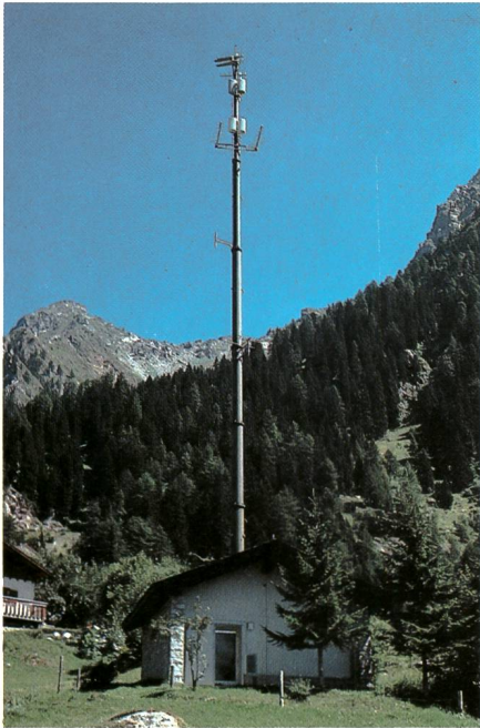
Fig. 5 Umsetzestation für den UKW- und Fernsehempfang in gebirgigem Gelände Ripetitore per la ricezione OUC e TV nelle regioni di montagna
