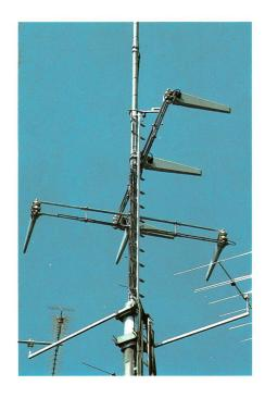
Antennenanlage für zwei Funkzellen mit sechs Richtstrahlantennen Impianto con sei antenne direttive per la copertura di due celle
