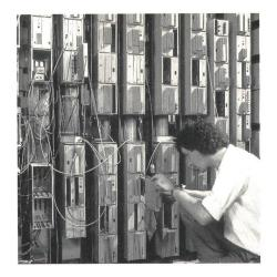
Fig. 2 Arbeit an einem 140-Mbit/s-System für optische Übertragung im Werk Huizen (NL)
