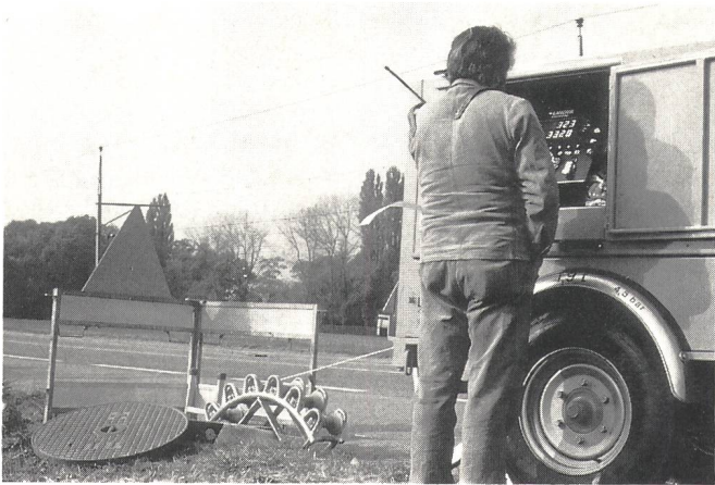
Fig. 12 Einzug des Glasfaserkabels mit Spezial-Zugwinde
