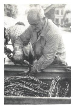
Fig. 7 Die ausgezogenen Kupferadern werden direkt in Containern untergebracht und anschliessend dem Altmaterialhandel zugeführt
