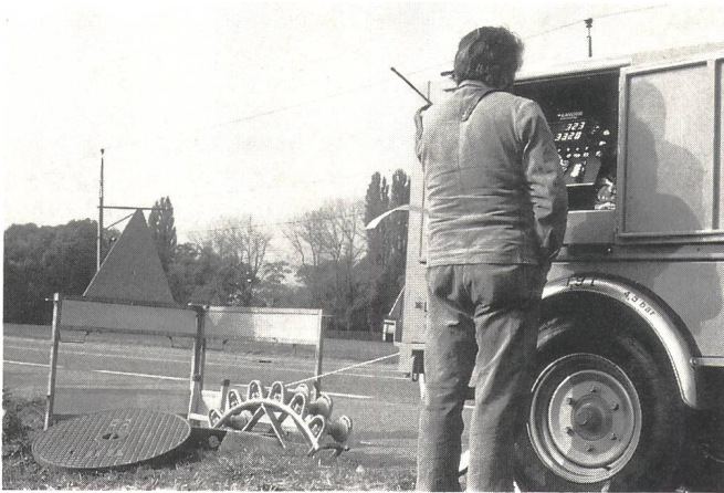
Fig. 12 Einzug des Glasfaserkabels mit Spezial-Zugwinde
