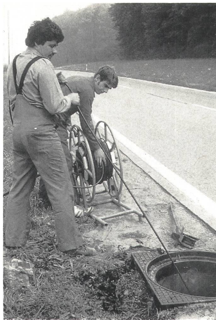
Fig. 9 Ausspülen des Bleirohres mit Hochdruckschlauch
