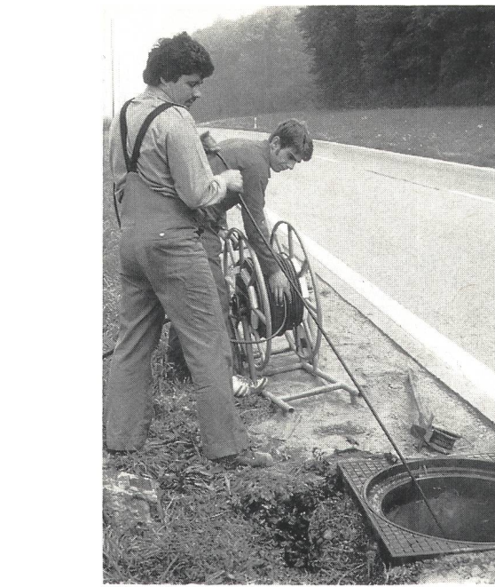
Fig. 9 Ausspülen des Bleirohres mit Hochdruckschlauch
