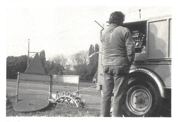
Fig. 12 Einzug des Glasfaserkabels mit Spezial-Zugwinde
