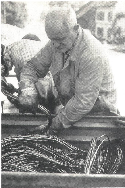
Fig. 7 Die ausgezogenen Kupferadern werden direkt in Containern untergebracht und anschliessend dem Altmaterialhandel zugeführt
