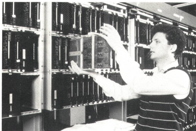
Fig. 5 Vista di una fila di telai
