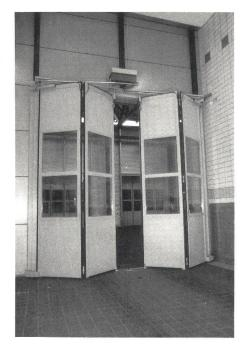
Fig. 4 Automatisches Falttor
