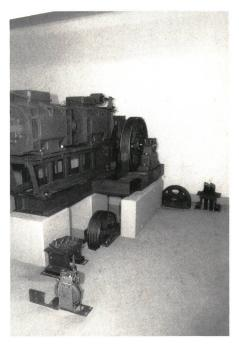
Fig. 2 Antrieb eines Lastenaufzugs 50 kN
