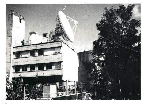
Die IBS-Satelliten-Bodenstation der PTT für besondere Geschäftsverbindungen über Intelsat mit den USA. Benützt wird ein Satellit im Westen des Atlantiks (deshalb die geringe Neigung der Antenne), damit Verbindungen mit den USA bis an deren Westküste möglich sind
