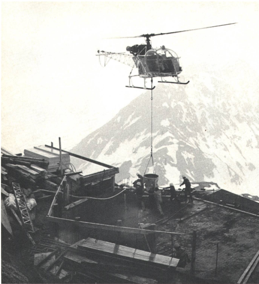
Fig. 2 Die hochalpine Baustelle war nur per Helikopter mit dem erforderlichen Material zu versorgen
