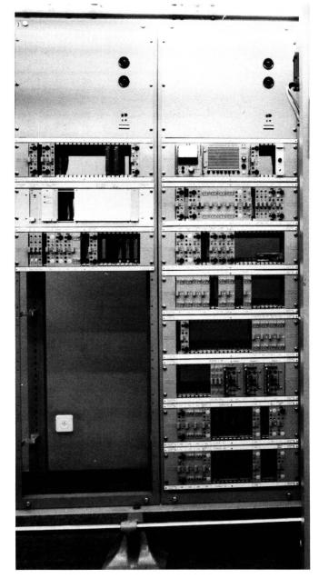
Fig. 6 Steuereinheit BC 11 für Relaisräume der SBB
