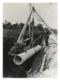
Fig. 2 Bau der Rohrleitung Genf-St. Gallen, 1921–1924 als Arbeitsbeschaffung erstellt. In ihr konnte zwischen St. Gallen und Wil das Glasfaserkabel eingezogen werden, ohne Strassen aufreissen zu müssen
