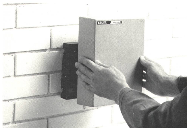
Fig. 6 Aufstecken des Apparateteiles – Innesto dell'apparecchiatura
