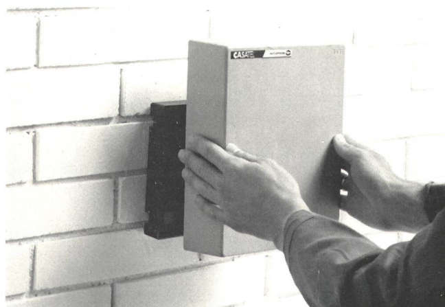
Fig. 6 Aufstecken des Apparateteiles – Innesso dell'apparecchiatura
