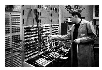
Connexion de circuits aux services des amplificateurs
