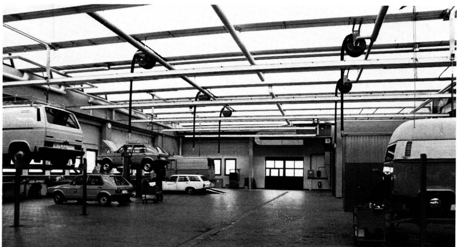
Fig. 2 Reparaturwerkstatt in der neuen Garage, wo kleinere Arbeiten ausgeführt werden
