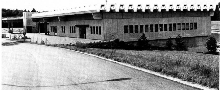
Fig. 1 Aussenansicht der neuen PTT-Garage Moncor bei Villars-sur-Glâne
