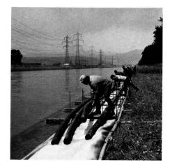
Fig. 2 Kunststoffrohrblock für den Limmatbereich. Montage am Linthkanal in Benken SG
