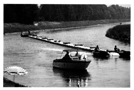
Fig. 4 Transport des 125 m langen Kunststoffrohrblocks im Linthkanal
