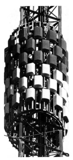
Fig. 3 UHF-Sendeantennen der TV-Station Barrie (Kanada)
