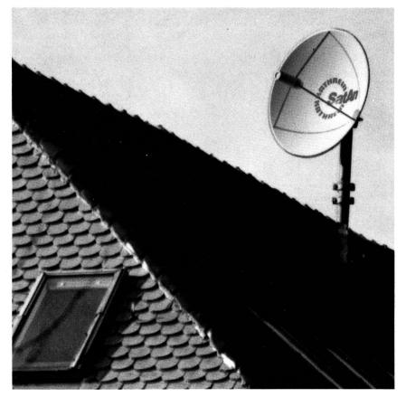
Fig. 2 1-m-Parabol zum Direktempfang von Rundfunksatelliten
