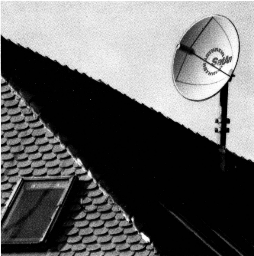
Fig. 2 1-m-Parabol zum Direktempfang von Rundfunksatelliten
