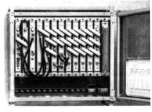
Fig. 5 Gehäuse mit den fernsteuerbaren Antennenkonvertern des Kabelpilotprojektes München (unten die dem Handwerk zugänglichen Teilnehmeranschlüsse)
