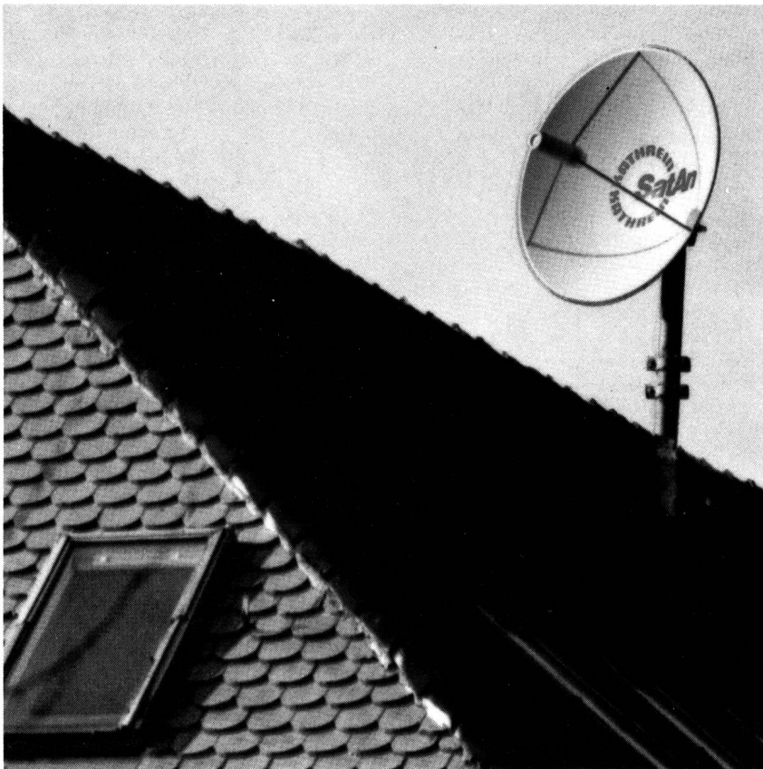
Fig. 2 1-m-Parabol zum Direkttempfang von Rundfunksatelliten
