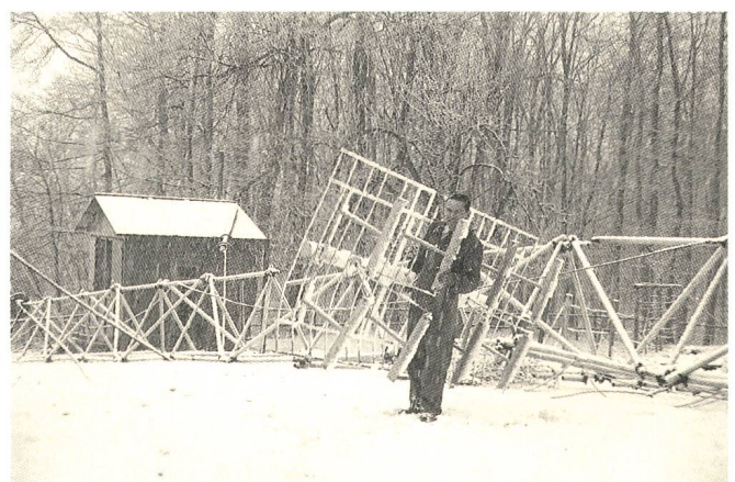
Zusammenbruch des ersten Fachwerkturns in Folge eines Schneesturms – Destruction de la première tour d'antenne par une tempête de neige (Foto: F. Grandchamp)
