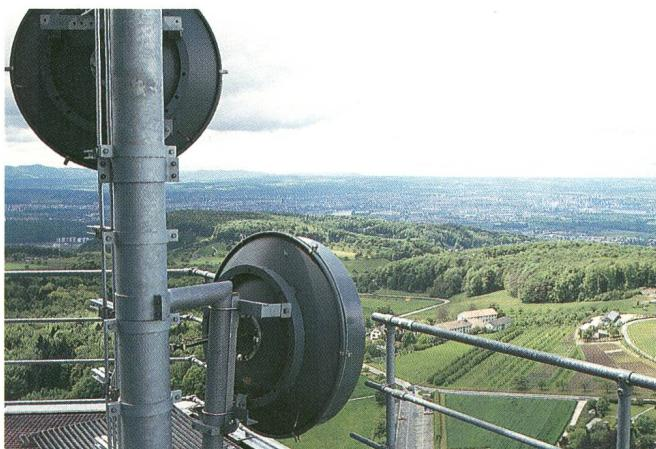
Parabolspiegel für Richtstrahlverbindungen auf einer Antennenterrasse – Paraboles pour liaisons par faisceaux hertziens sur une terrasse d'antennes
