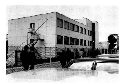
Das neugeschaffene Chemielaboratoriums-Gebäude, ein vierstöckiger Betonskelettbau ausgefacht mit Backsteinmauerwerk und Eternit-Vorhangfassade. Das sogenannte Technikum nimmt das gesamte Erdgeschoss ein, ein Saal, in dem Prozesse unter fabrikationsähnlichen Voraussetzungen durchgeführt werden können
