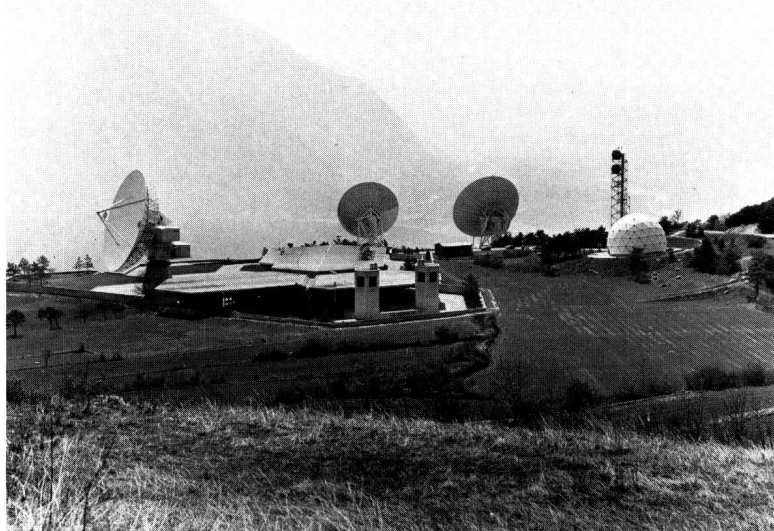
So zeigt sich heute das Plateau von Brentjong oberhalb Leuk mit seinen drei Antennen – zwei in Richtung West, eine in Richtung Ost –, dem Betriebsgebäude und dem Ausstellungspavillon
