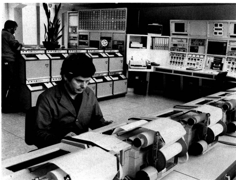
Der Kontrollraum, das zentrale Nervensystem der weltweiten Verbindungen des Betriebszentrums Telekommunikation
