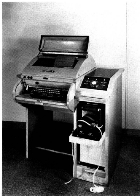
Téléimprimeur Siemens T 37 et transmetteur de bande perforée Lorenz
