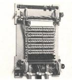
Coffret de raccordement avec module de déconnexion LSA
