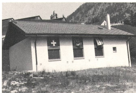
Fig. 1 Das neue Zentralengebäude in Simplon Dorf fügt sich unauffällig in das südlich anmutende Gebirgsdorf (Figur 3) ein
