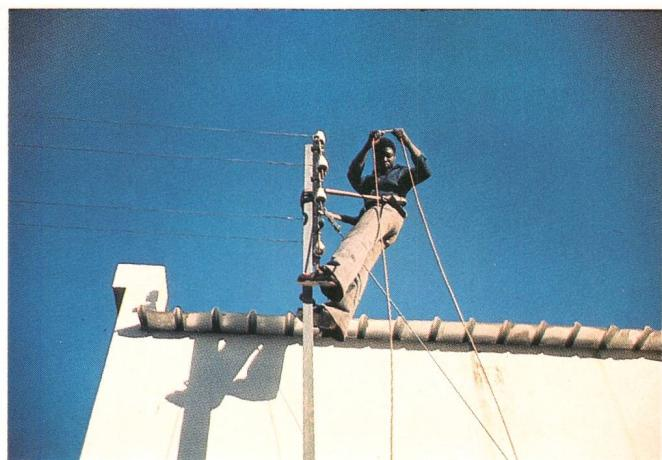
Ausbau eines oberirdischen Leitungsnetzes
