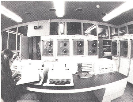
Betriebsraum mit Konsole und Magnetbandstationen
