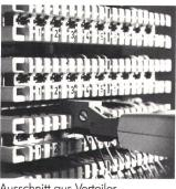
Ausschnitt aus Verteiler mit aufgesetztem Werkzeuganleger
