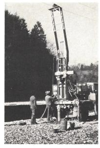
Fig. 1 Rotationskernbohrung RB 1, Seite Löchligut. Bohreinrichtung fahrbar, auf Unimog montiert
