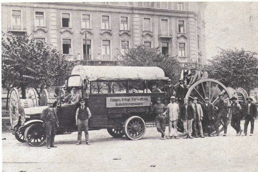
Kabelrollentransport mit einem vollgummibereiften (ehemaligen Armee-)Lastwagen. Der Umgang mit diesen Fahrzeugen musste damals auch bei den Mitarbeitern von Telefon und Telegraf erst publik gemacht werden (Archivbilder «TM PTT»)
