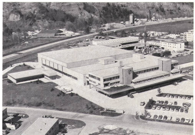
Fig. 1 Ansicht von Süden
