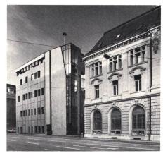
Fig. 1 Un premier volume, l'Ancienne Poste, solide, imposant par sa masse et sa stature, et un second volume massif, en éléments préfabriqués de béton sablé, destiné à contrebalancer le poids de l'Ancienne Poste
