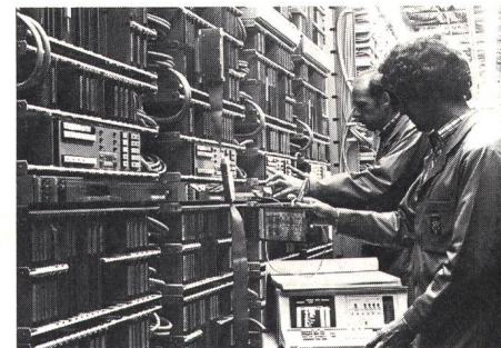
Testarbeiten an den mikrocomputergeteuerten elektronischen Multiregistern
