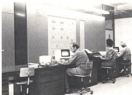
Zentraler Mess- und Prüfraum der Hauptzentrale
