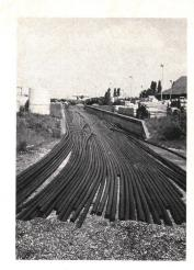
Fig. 5 Handwerker der Bauunternehmung erstellen ein geordnetes Lager für die 106 m langen Kunststoffrohre, die die Kabelzugequipe von den SBB-Güterwagen auf das Autobahn-Werkhofareal gezogen hatte
