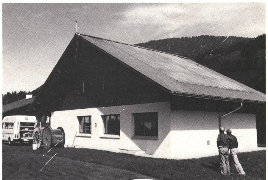
Fig. 1 Zentralengebäude (Typ 1) Feutersoey mit den in die südliche Dachhälfte integrierten Sonnenkollektoren
