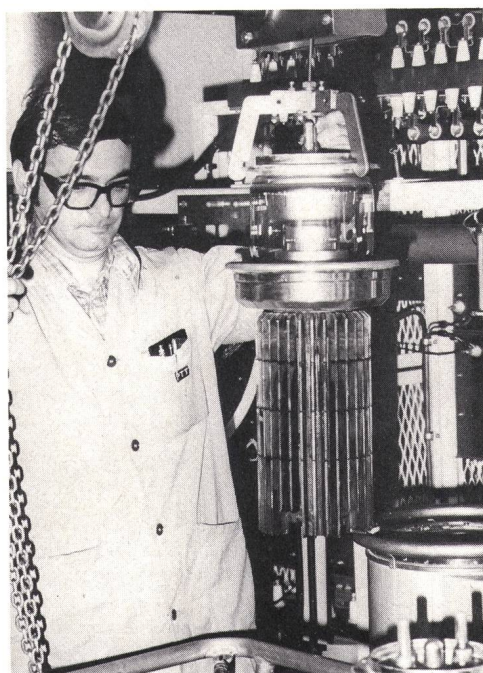
Röhrenwechsel in der Modulatorenendstufe eines modernen Mittelwellensenders — Changement de tube dans l'étage final de modulation d'un émetteur à ondes moyennes modernes
