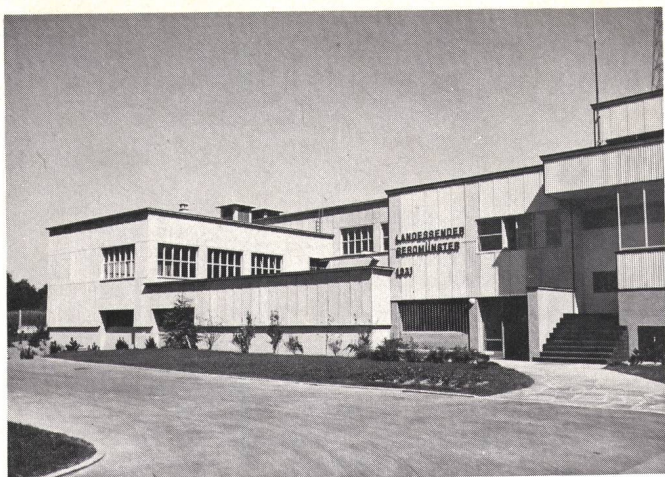
Landessender Beromünster: Das 1939 erweiterte Sendergebäude — Emetteur national de Beromünster: Bâtiment des émetteurs, agrandi en 1939
