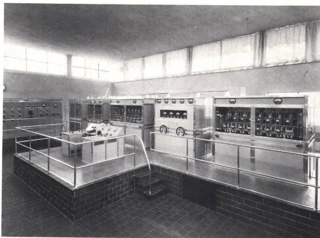
Landessender Beromünster: Der 1939 erstellte 150-kW-Mittelwellensender — Emetteur national de Beromünster: Emetteur à ondes moyennes de 150 kW, construit en 1939
