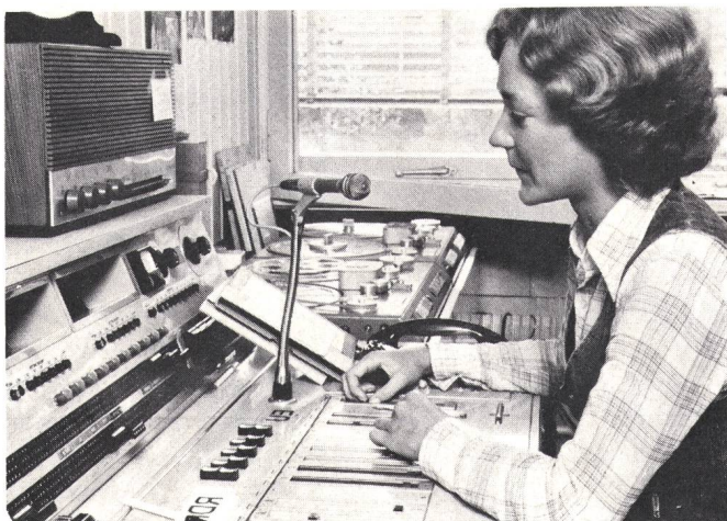
Telefonrundspruch: Ansage-, Schalt- und Kontrollpult in der Koordinationsstelle der SRG in Bern — Télédiffusion: Pupitre d'annonce, de commutation et de contrôle du centre de coordination de la SSR à Berne
