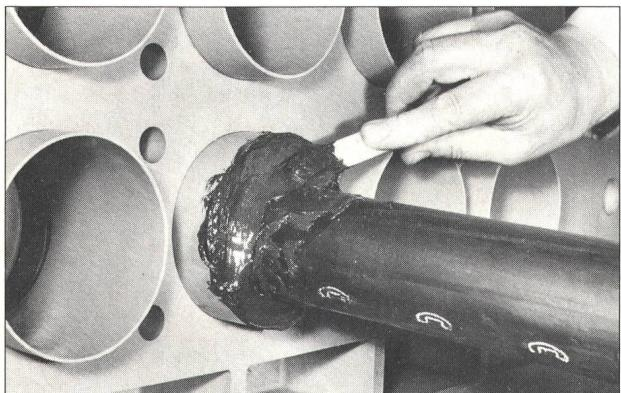
Scotchcast 9580 ist ein spachtelbares, elastisches Polyurethan-Harz: für garantierter gas- und wasserdichte Abdichtungen von Kabelkanälen, Kabel-, Gas- und Wasserröhreinführungen in Gebäude; auch für Dichtungen zwischen Rohr und Mauerwerk.
