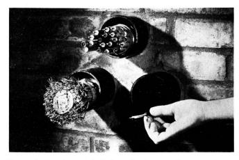
Une seule fibre de verre (à droite en bas) permet de transmettre au moins autant de conversations que des câbles ordinaires à plusieurs paires de conducteurs ou des câbles coaxiaux (à gauche, en bas et en haut) — With a single optical fibre (below right) at least as many telephone calls can be established as with ordinary multiwires or coaxial cables (below and above left)
