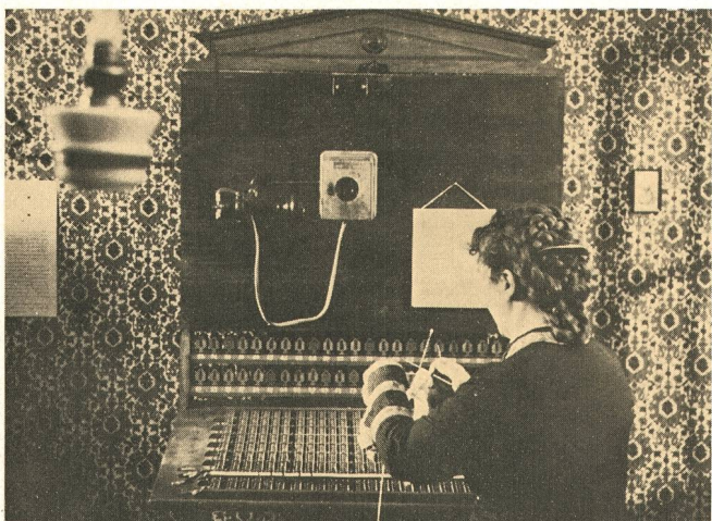
Commutateur Gilliland, tel qu'il était utilisé dans les premiers centraux des réseaux urbains de Zurich, de Bâle et de Berne — Gilliland-switch as installed in the earliest exchanges of the cities of Zurich, Basle and Berne
