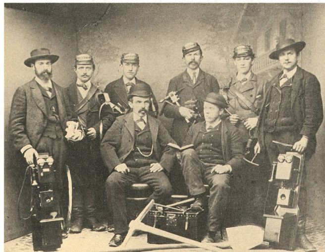
Monteurs de la Société zurichoise des téléphones (1884) — Telephone installers of the Zurich Telephone Co (1884)
