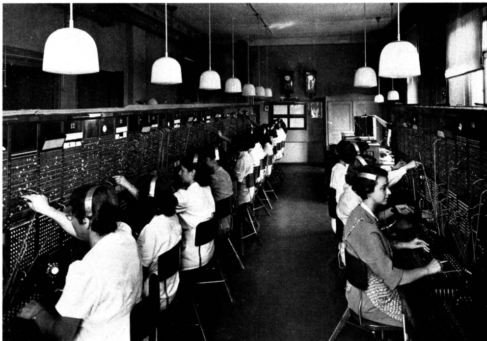
Central téléphonique manuel (Locarno 1950) avec sélection interurbaine automatique pour la téléphoniste («Service rapide») — Manual telephone exchange (Locarno 1950) with automatic trunk call selection by the operator («speedy traffic»)
