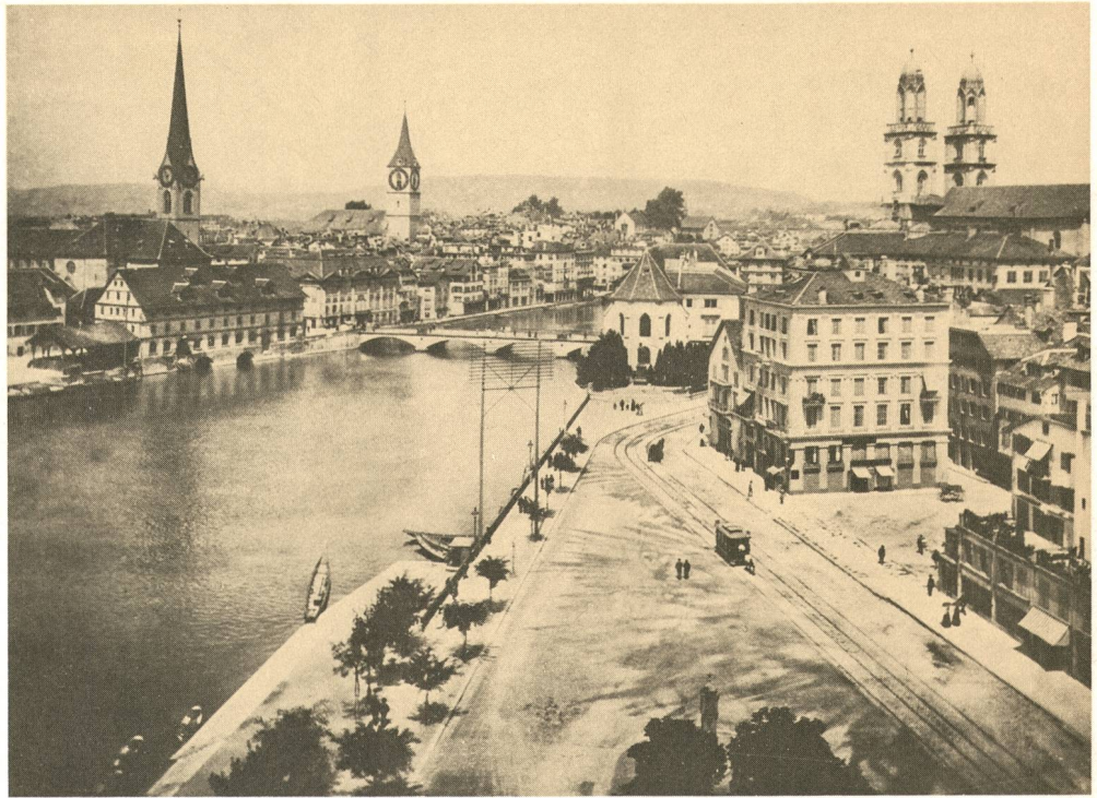
Support de ligne téléphonique au Limmatquai (vers 1900) — Telephone lines at Limmatquai (around 1900) (Photo: Baugeschichtliches Archiv Zürich)
