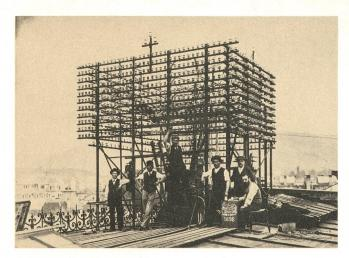
Support central sur le toit du deuxième central téléphonique de Zurich à la Kappelergasse avec l'équipe de monteurs — Roof top overhead lines with installers of the second Zurich telephone exchange at the «Kappelergasse» (Photo: Baugeschichtliches Archiv Zürich)
