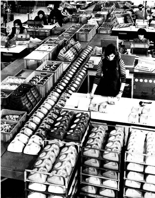
Die Zusammenarbeit zwischen der Fernmeldeindustrie und den PTT-Betrieben findet ihren Niederschlag nicht nur in den Materiallieferungen . . . – La collaborazione tra l'industria delle telecomunicazioni e l'Azienda delle PTT non si ripercuote solo nella fornitura di materiale...
